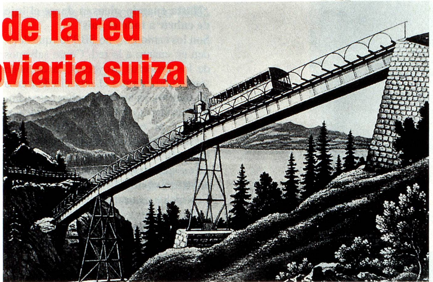
El viaducto Schnurtobel del ferrocarril Vitznau-Rigi según un cuadro pintado en 1871. (Fotos: Max Baumann)
