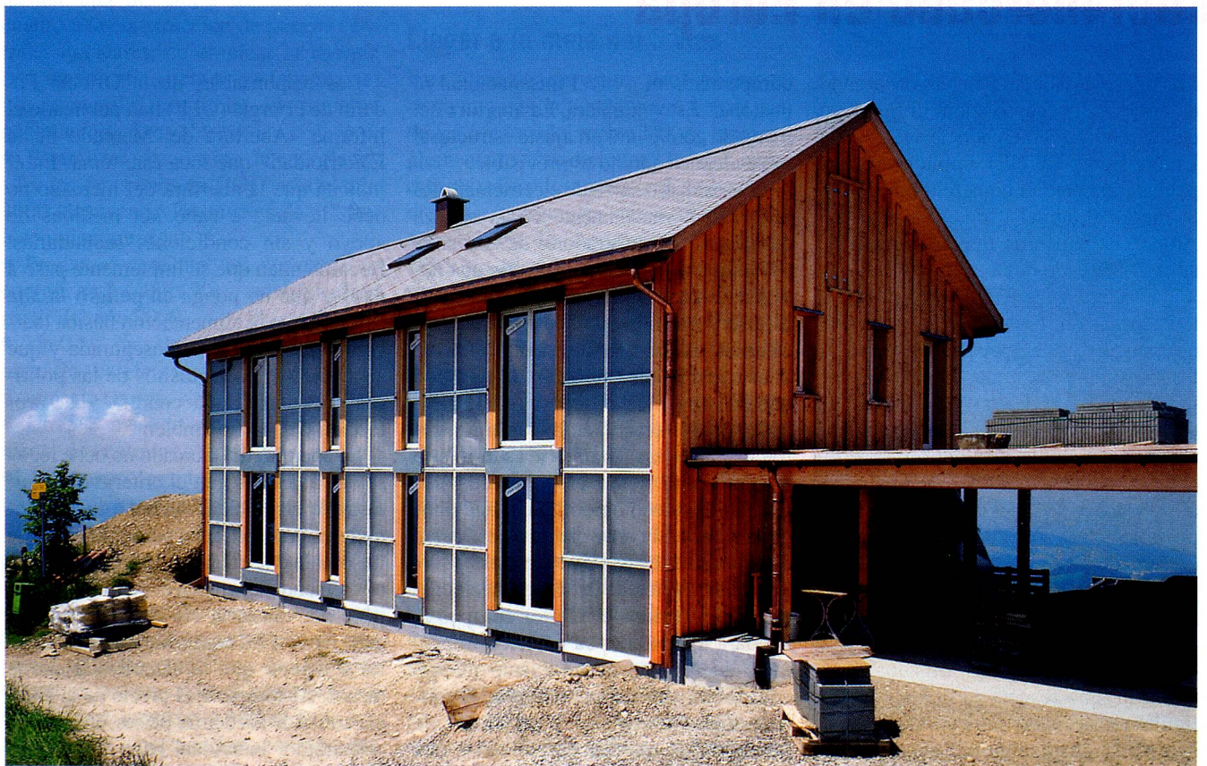
Un proyecto piloto en el cantón de Appenzel: las paredes de la fachada suministran energía solar gracias al aislamiento transparente, fruto de la nueva técnica. (Foto: Oerlikon Journalisten)
