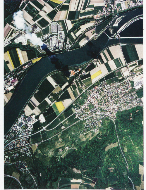
El río Aare y la central nuclear de Leibstadt, 1991
