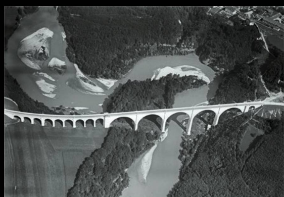
Puente carretero de Pérolles, Friburgo, fotografiado en 1926.
