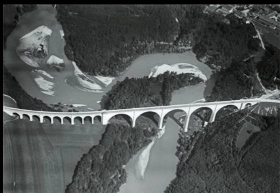
Puente carretero de Pérolles, Friburgo, fotografiado en 1926.
