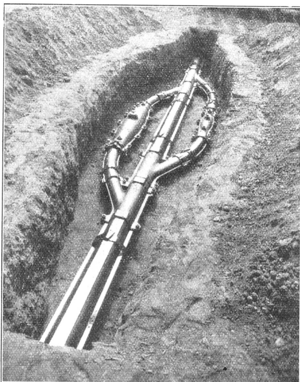
Fig. 5. Einbau der Muffen in den Zoreskanal.
