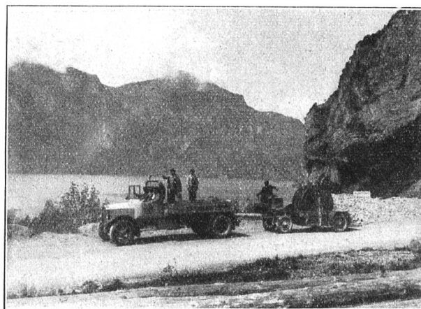
Fig. 15. Kabeltransport an der Axenstrasse.
