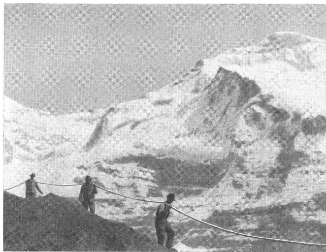
Fig. 4. Kabelauftragung auf der Wengernalp. Transport du câble à la Wengernalp.
