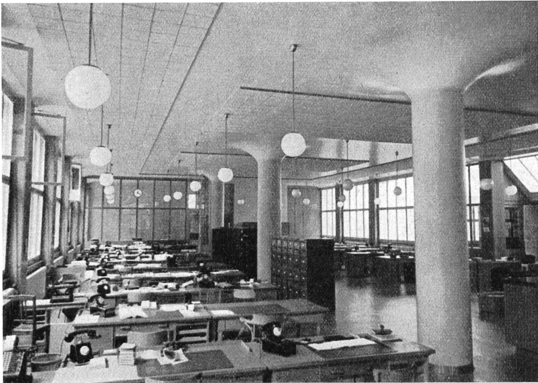
Fig. 11. Schalterhalle Zürich. — Hall des guichets, Zurich.
