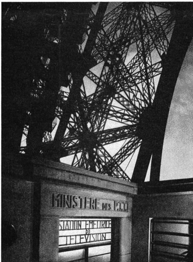
Fig. 1. Fernsehsendezentrale des Eiffelturms. Centre émetteur de télévision de la Tour Eiffel.
