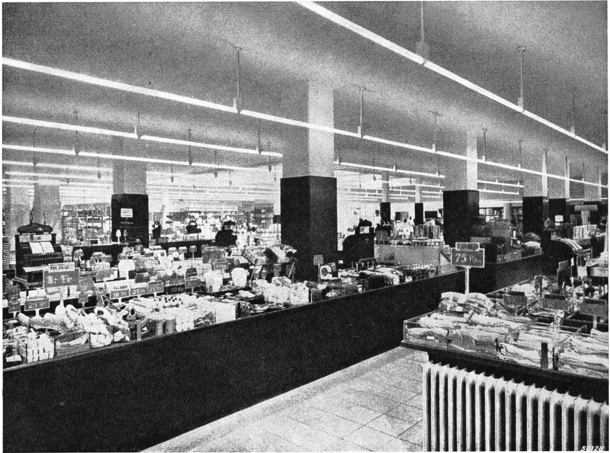
Abb. 9. Anwendung der Hochspannungs-Niederdruck-Leuchtstoffröhren.
