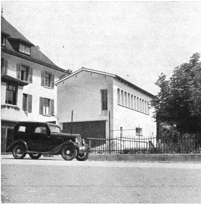
Abb. 2. Nach dem Umbau.
