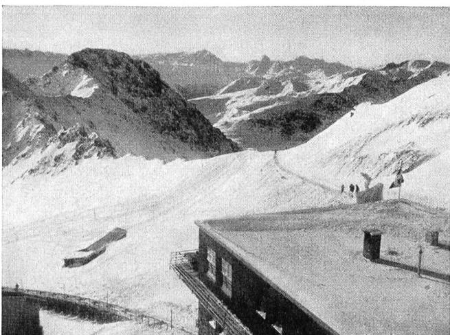
Abb. 6. Weissfluhjoch, Endstation der Parsennbahn.
