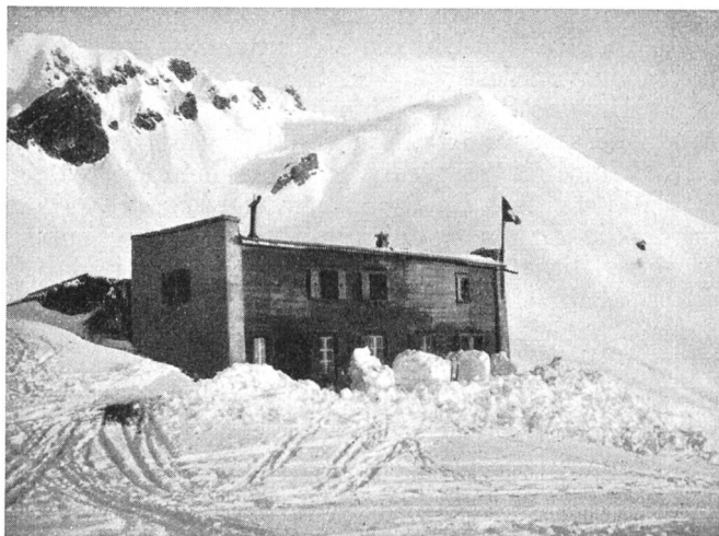
Abb. 10. Skihütte Parsenn bei Davos.
