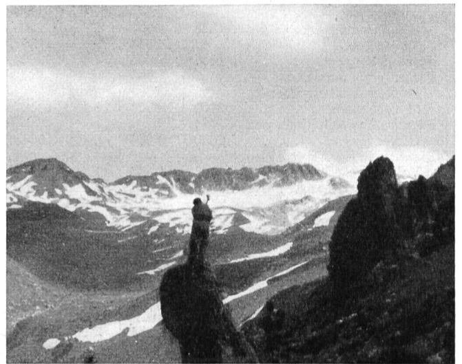
Abb. 5. Bohrarbeiten an Felsköpfen für Weitspannung zur Keschhütte.
