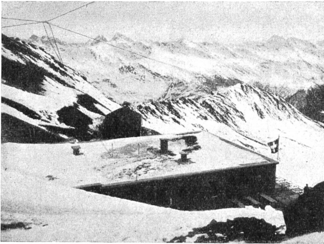
Abb. 8. Station Weissfluhjoch mit Telefonleitung als Weit- spannung.
