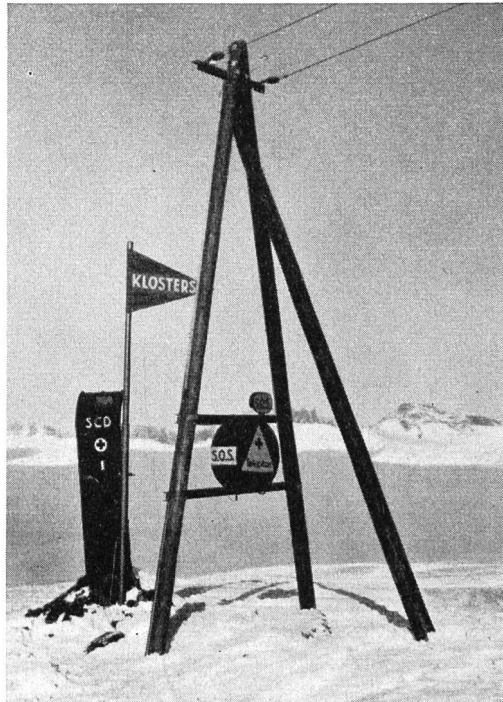
Abb. 7. S. O. S.-Telephonstation „Kreuzweg“ auf der Parsennroute von Davos nach Küblis und Klosters.
