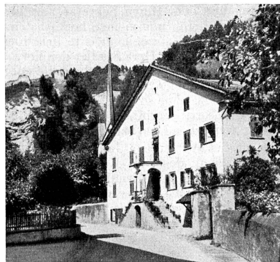
Abb. 20. Das vornehme „Heim“ einer Landzentrale.
