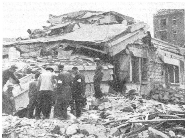
Fig. 1. Etat de la station de répéteurs d'Annecy après le bombardement du 10 mai 1944
