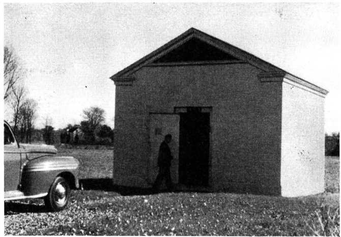
Fig. 8. Verstärkerstation für Koaxialkabel (Aussenansicht)
