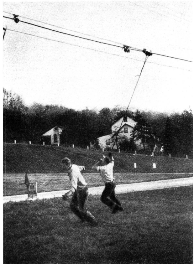
Fig. 18. Verlegung eines Luftkabels mit dem «cable lasher»
