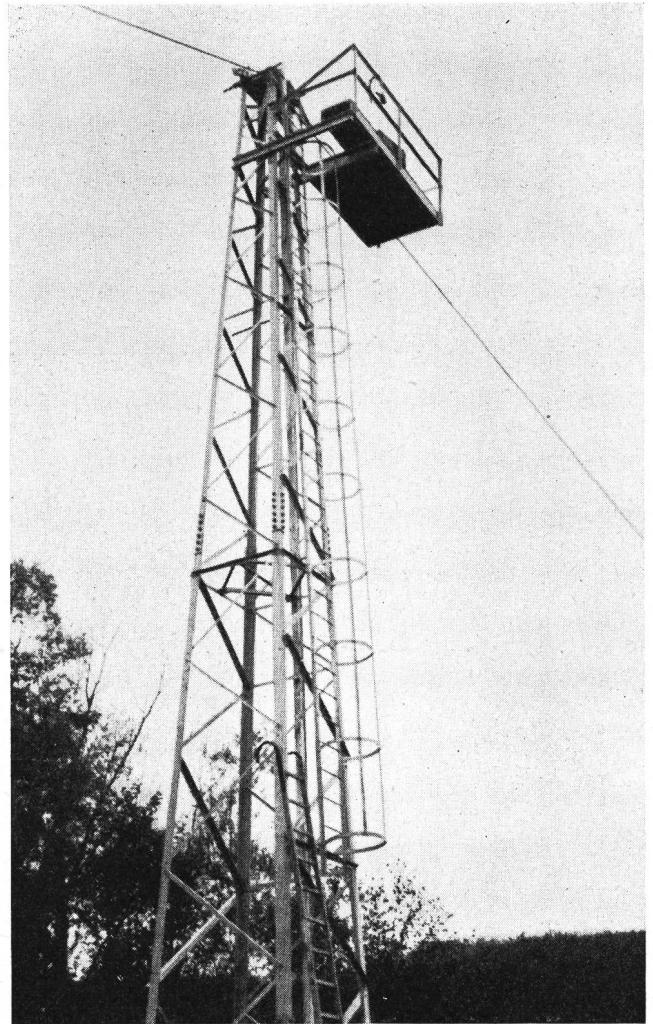
Fig. 3. Mast mit Montagegerüst Pylône équipé du dispositif de montage
