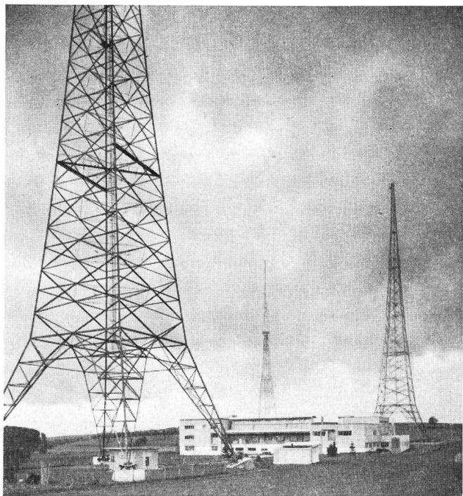
Fig. 6. Vue des anciens pylônes et façade est du bâtiment. Sous le pylône de gauche, la guérite de couplage feeder-antenne. A noter dans la partie centrale du bâtiment, la galerie de prise d'air des réfrigérants
