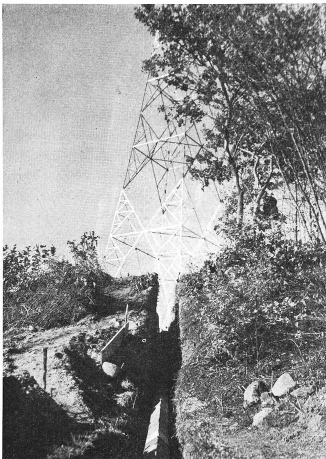
Fig. 9. Vue d'une tranchée pour la pose du câble.
