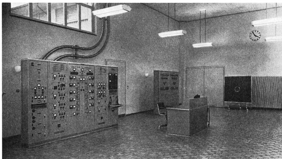
Le programme est contrôlé au moyen d'un *modulomètre* se composant d'un amplificateur à alimentation stabilisée suivi d'un redresseur à caractéristique logarithmique donnant, sur un instrument gradué en népers et de faible inertie, la valeur instantanée du niveau d'entrée. Un deuxième appareil de mesures, en série avec le premier et à spot lumineux, est placé sur le pupitre de contrôle.
