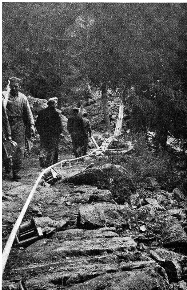
Fig. 5. Kabeltransport von Hand, mittels Laufrollen, wenn der Haspel nicht mit dem Motorfahrzeug zum Kabelgraben geführt werden kann
