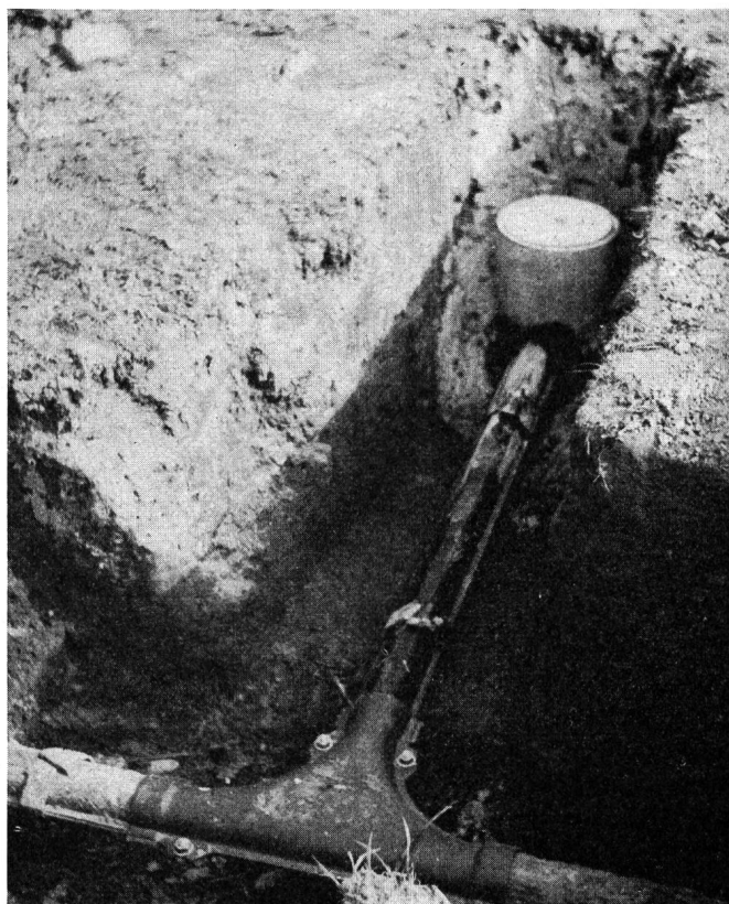
Fig. 4. Fertig montierte Magnesiumanode. Vorne sieht man den Anschluss der Anode an das Kabel, im Hintergrund direkt über der Anode ein Standrohr mit einer Trennstelle, in der jährlich einmal der Strom kontrolliert wird. Anode de magnésium montée définitivement. A l'avant, on voit le raccordement de l'anode au câble, à l'arrière, directement au-dessus de l'anode, un tube vertical avec point de coupure dans lequel on peut contrôler le courant une fois par année
