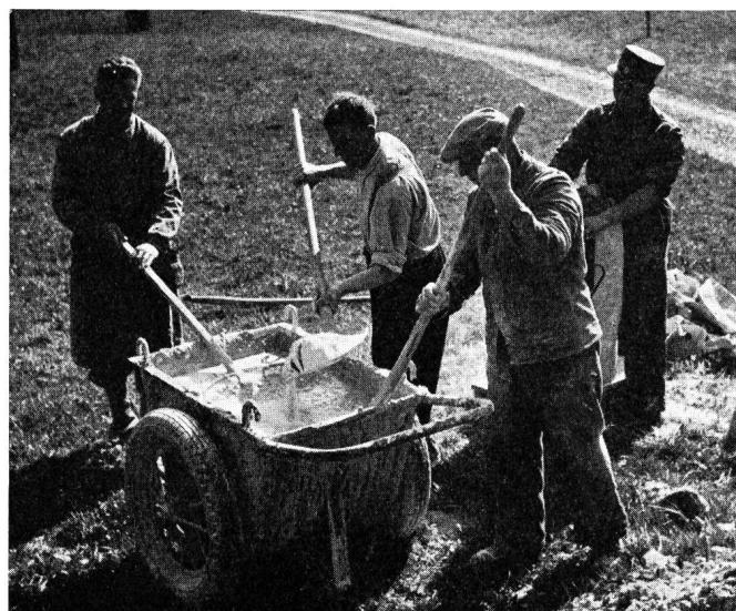
Fig. 3. Mischen der Bentonitmasse für eine Magnesiumelektrode Mélange de la masse de bentonite pour une électrode de magnésium Photographie: F. Fehlmann, Luzern
