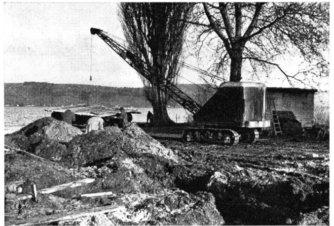
Fig. 1. Die Kabel-Baustelle in Meyriez
