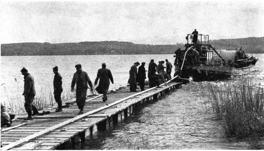
Fig. 5. Das Küstenstück des Kabels ist im Zoreskanal zur Versenkung bereit
