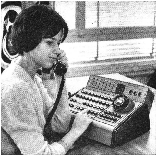
Fig. 2. Albis-Vermittlungstation mit Leuchttasten und eingebautem Nummernanzeiger
