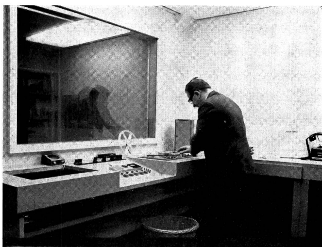
Der Apparate- und Regieraum der CRR in Chur
