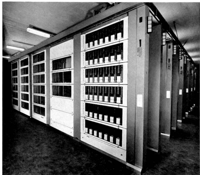
Fig. 10 Erste Pentaconta-Zentrale der Schweiz in Regensdorf. 6000 Anschlüsse, ausbaubar auf 10 000. Eingeschaltet am 28. September 1966 Premier central Pentaconta établi en Suisse, à Regensdorf. 6000 raccords, extension possible à 10 000. Mis en service le 28 septembre 1966
