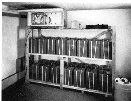
Fig. 2 Sender (oben) mit Primärbatterie 36 V / 10 000 Ah
