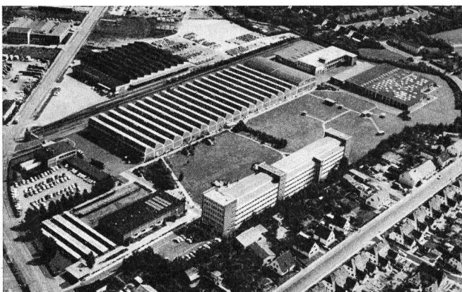
Fig. 1 Luftaufnahme des Nordmende-Industriearals an der Funkschneise in Bremen-Hemelingen. Der langgestreckte Shedbau beherbergt auf über 17 000 m 2 das Fernsehwerk (mit einer Tagesproduktion von über 1000 Stück) sowie die Nebetriebe für Tunerbau und -prüffeld. Unten im Bild der Bau, der das Entwicklungszentrum (5000 m 2 ) und die Verwaltung beherbergt. Ausserhalb liegen das Rundfunkwerk sowie die Zweigwerke Wildeshausen und das diesen Sommer die Produktion aufnehmende Werk Bremerhaven (20 000 m 2 )
