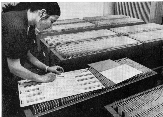
Fig. 1 Schuppenkartei bei der GD PTT in Bern; bei den in fahrbaren Behältern eingereihten Planetten werden die Änderungen – wie zum Beispiel Neuanschlüsse oder Adressänderungen – laufend nachgeführt
