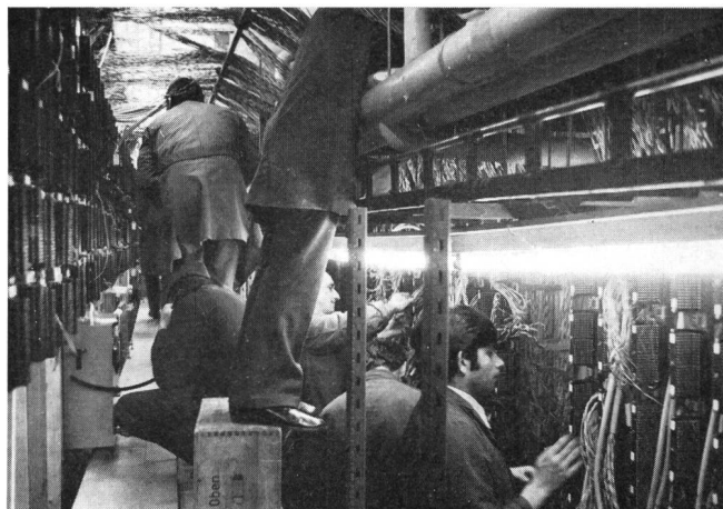
Fig. 14 Überführungs- und Kablierungsarbeiten am provisorischen Hauptverteiler Etablissement des renvois et du câblage au répartiteur principal provisoire
