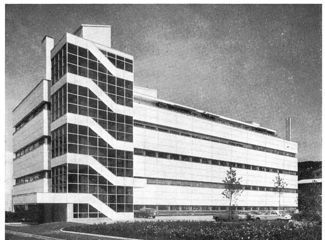
Fig. 1 Gebäude des Fernbetriebszentrums St. Gallen-Lachen
