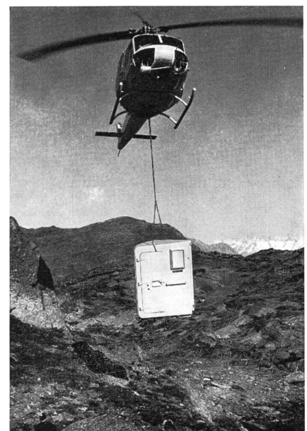
Fig. 2 Transport eines Kabinenelementes – Transport d'un élément de cabine
