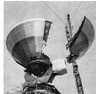
Fig. 2 Montage des Antennenspiegels der dritten Antenne der Satelliten-Bodenstation Raisting
