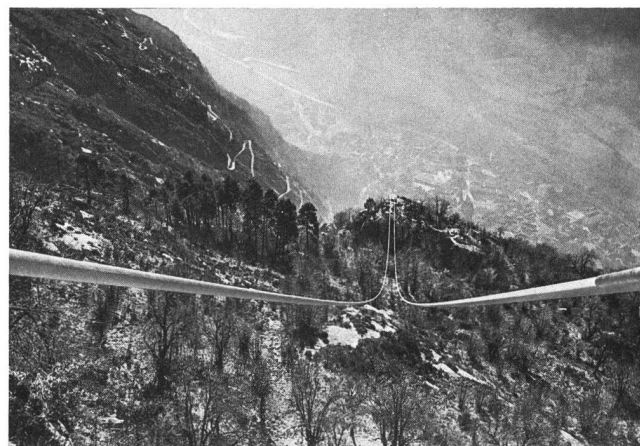
Fig. 20 b) Oberer Teil der Weitspannung in Bodio – Partie supérieure de la longue portée de Bodio
