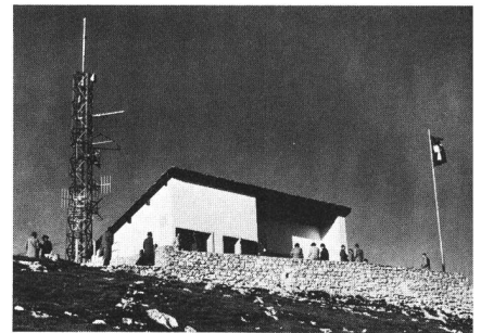
△ Die Richtstrahlstation Chasseral im Jahre 1947... – La station à faisceaux hertziens du Chasseral en 1947...
