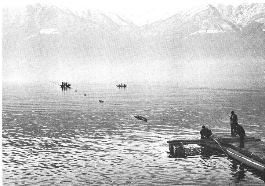
Fig. 6 Posa del cavo da Muralto in direzione di Vira. I galleggianti sono ben visibili
