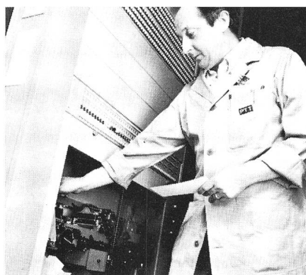
Der PTT-Fernmeldespezialist entnimmt dem Stanzer die Lochkarte
