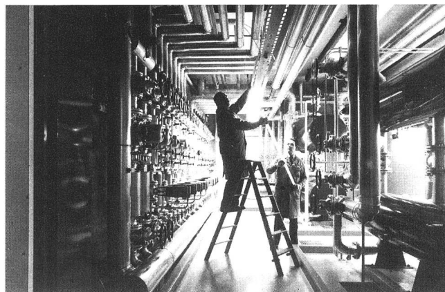
Fig. 5 Heizungsunterstation, rechts Wärmeumformer, links Wärmeverteilstation – Sous-station de chauffage, à droite l'échangeur de chaleur, à gauche la station de distribution calorifique
