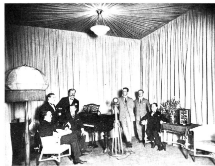
Fig. 2 Das «Studio» von Radio Zürich im Amtshaus IV, wie es 1925 aussah, aufgenommen mit einigen Mitwirkenden. Neben diesem Raum befand sich jener mit den technischen Einrichtungen, der zugleich auch als Büro diente
