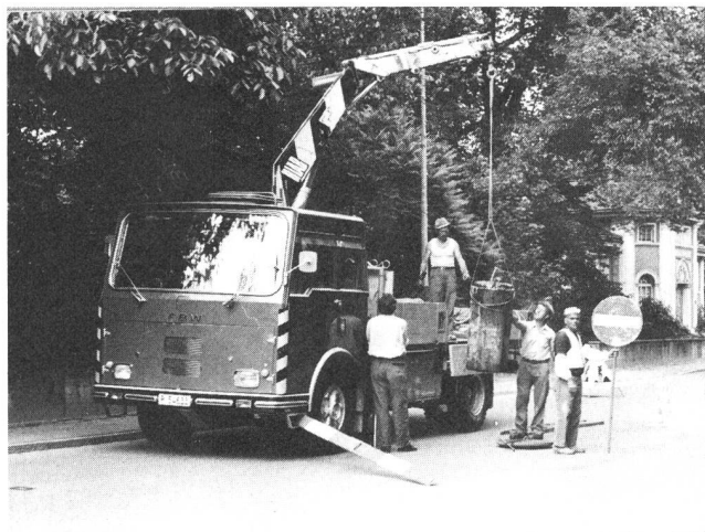
Fig. 8 Verlad der alten Pupintöpfe – Prise en charge des anciens caissons Pupin
