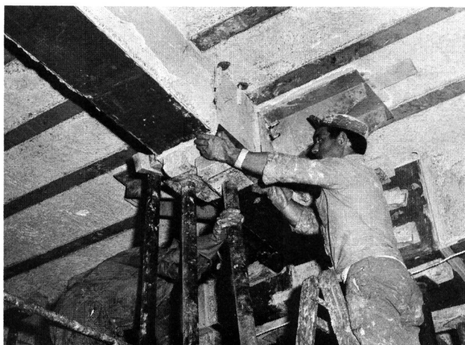
Fig. 2 Anbringen der Verstärkung
