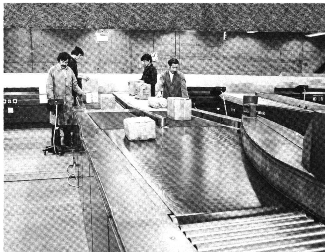
Fig. 6 Eingabeteil der Sortieranlage des Paketversandes – Place d'introduction de l'installation de tri de l'expédition des colis
