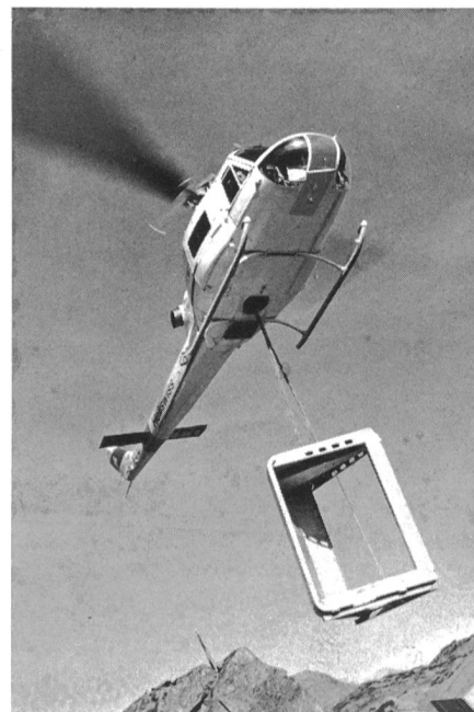
Fig. 6 Transport eines Kabinenteils anlässlich der Montage eines Umsetzers im Hochgebirge — Transport d'un élément de cabine à l'occasion du montage d'un réémetteur en haute montagne
