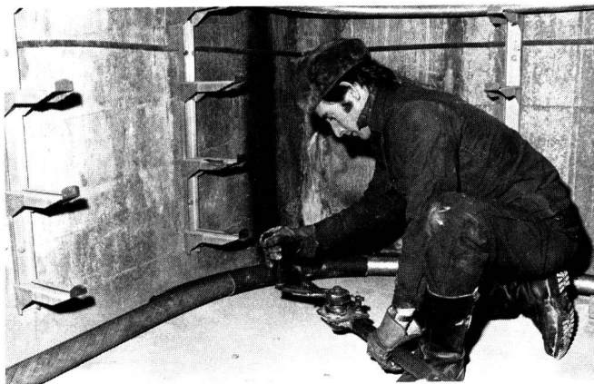
Fig. 13 Zum Abbiegen des Kabels in kurze Bogen mussten, damit das Kabel nicht beschädigt wurde, dem Kabeldurchmesser genau angepasste Rohrhalschalen und entsprechende Rätchenwerkzeuge verwendet werden — Per la curvatura del cavo in piccoli raggi, senza danneggiarlo, si dovette far uso di speciali attrezzature e forme perfettamente adattate al diametro del cavo stesso
