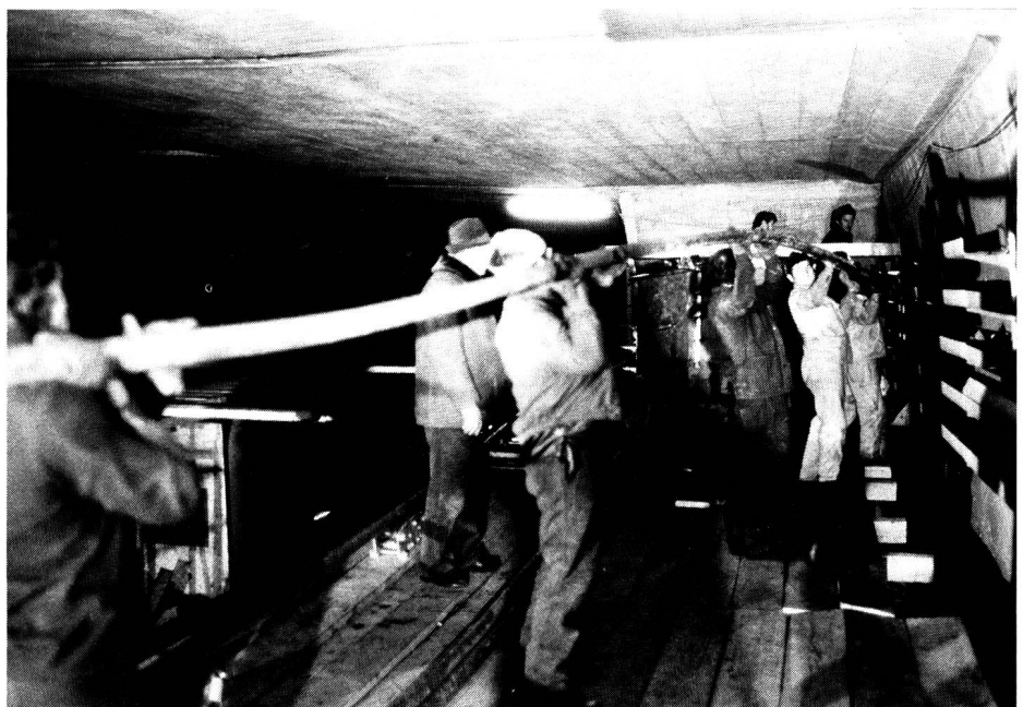
Fig. 12 Verlegung des Kabels in den Wandkanal — Posa del cavo nel canale murale
