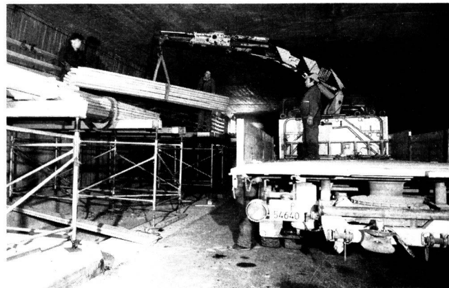
Fig. 14 Unmittelbar nach Beendigung des Kabelzuges und der Kabeleinführung in die Spleissnische wird hier das nicht mehr benötigte Arbeitspodest in der einen der Ausstellnischen abgebrochen und in die nächste Nische verlegt — Immediatamente dopo l'ultimazione dei lavori di tiro e di introduzione del cavo nella nicchia di giunzione, la piattaforma, divenuta libera, veniva smontata e rimontata al prossimo posto di lavoro
