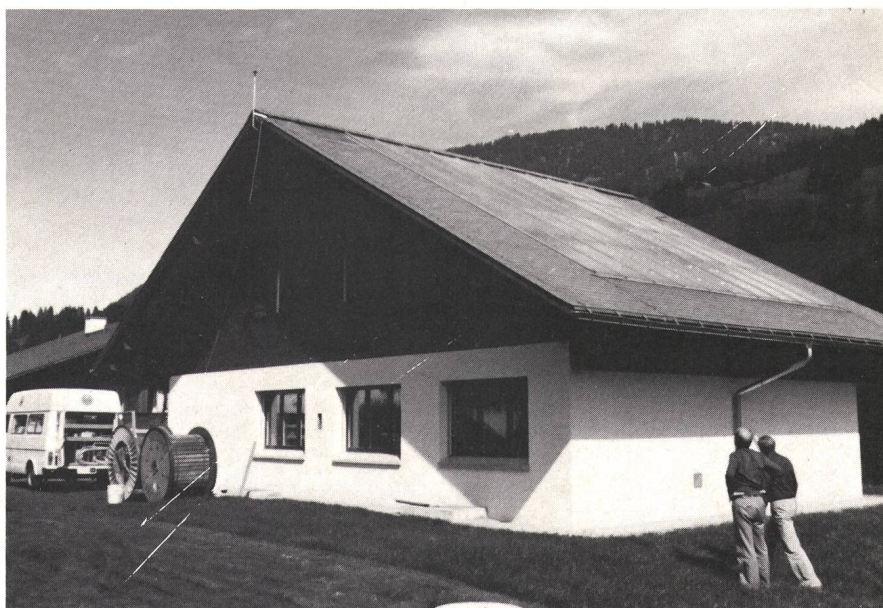
Fig. 1 Zentralengebäude (Typ 1) Feutersoey mit den in die südliche Dachhälfte integrierten Sonnenkollektoren
