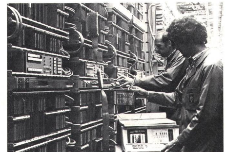
Testarbeiten an den mikrocomputergeteuerten elektronischen Multiregistern
