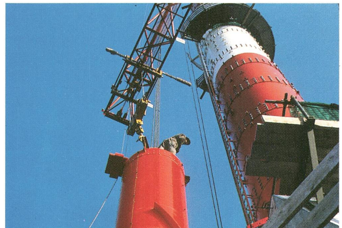
Montage des 100-m-hohen Rohrmastes – Montage du mât d'acier de 100 m de hauteur
