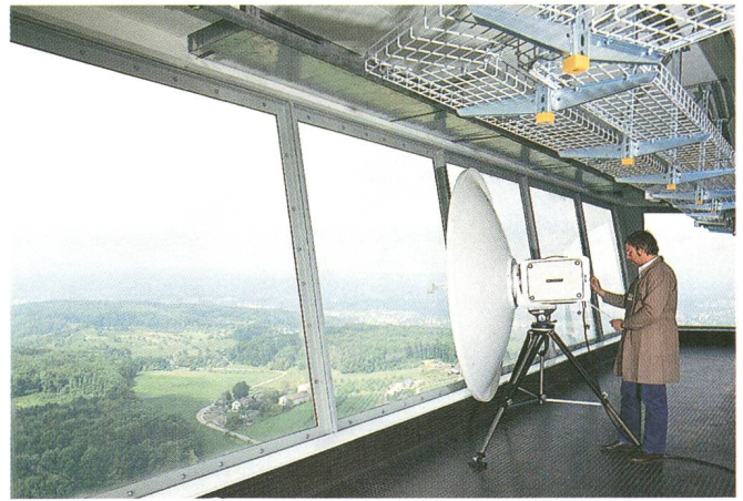
Raum im obersten Turmausbau (+ 138 m) für temporäre und Reportage-Richtstrahlverbindungen – Local dans l'élément saillant le plus élevé de la tour (+ 138 m) pour liaisons à faisceaux hertziens temporaires et de reportage
