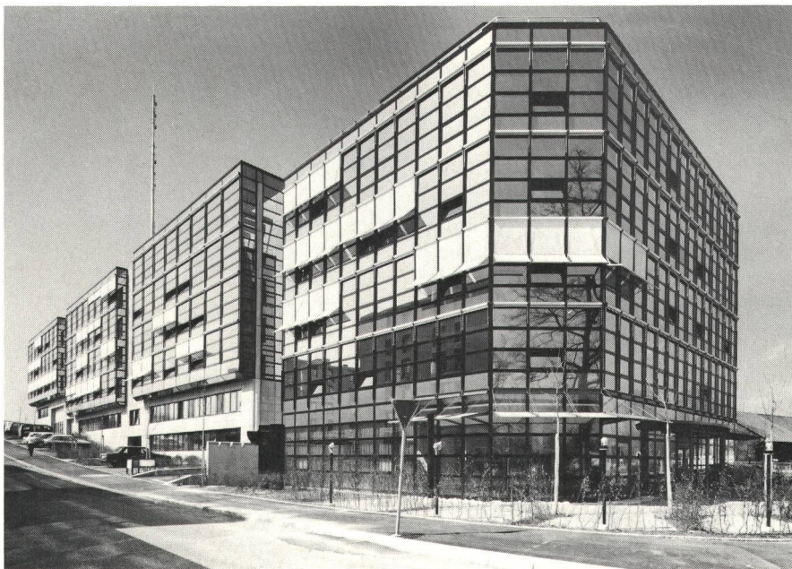
Fig. 1 Die der Autobahn abgekehrte Seite des rund 100 m langen Bürogebäudes der ascom. Im Vordergrund die Restaurant-Gartenterrasse
