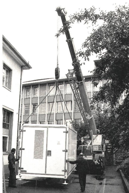
Fig. 4 Aufstellung des Containers mittels eines Krans – Mise en place du conteneur au moyen d'une grue
