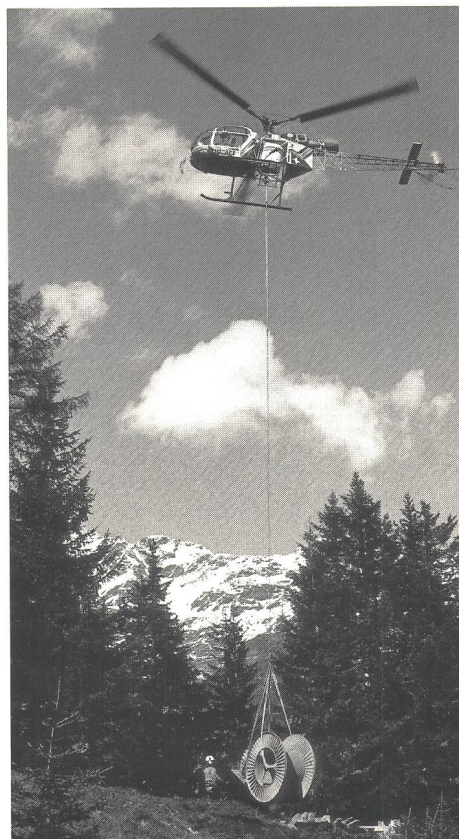
Fig. 6 Transport von Kabeltrommel und Montagmaterial in unwegsamem Gelände
