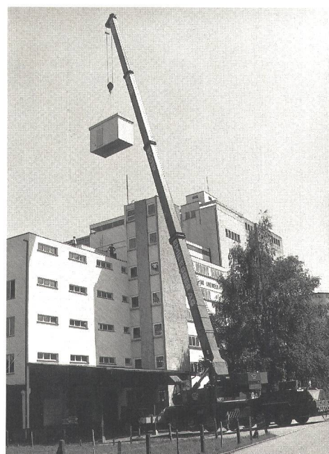
Fig. 4 Montage einer Kabine mit pneumatischem Hebekran. Zeitaufwand 1 Std.
