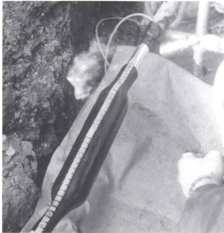
Installation einer XAGA-500-Verbindungsmuffe mit integrierter Feuchtigkeitssperre
