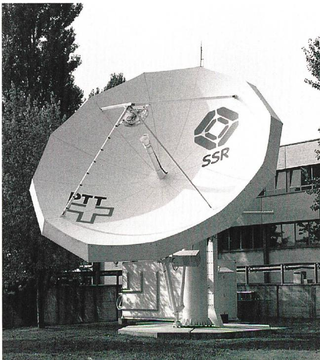
die TVO-Antennen ein G/T-Wert von 33 dB/K zugrunde gelegt. Dieser Wert kann heute mit ungekühlten RF-FET-Verstärkern mit einer Rauschtemperatur von 170 K und einem Antennendurchmesser von 7 bis 8 m erreicht werden. Der bewertete Signal-Geräusch-Abstand der empfangenen Programme beträgt rund 60 dB bei nominaler Up-link-Sendeleistung, was einer guten Bildqualität entspricht.
