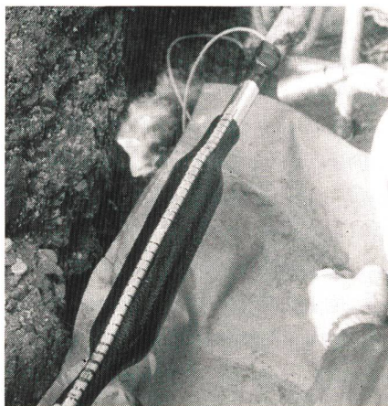
Installation einer XAGA-500-Verbindungs-muffe mit integrierter Feuchtigkeitssperre
