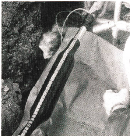
Installation einer XAGA-500-Verbindungs-muffe mit integrierter Feuchtigkeitssperre
