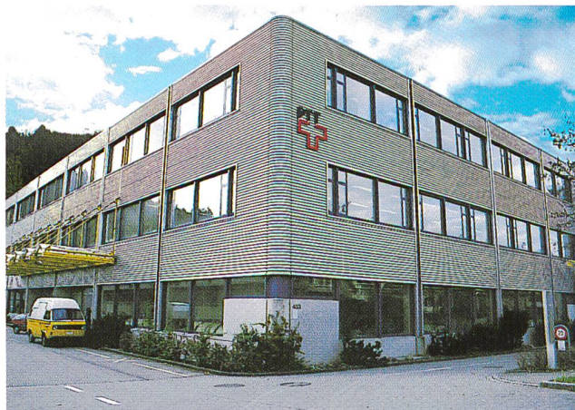
Bild 1. Rechenzentrum I der Direktion Zahlungsverkehr PTT am Stadtrand von Bern.
